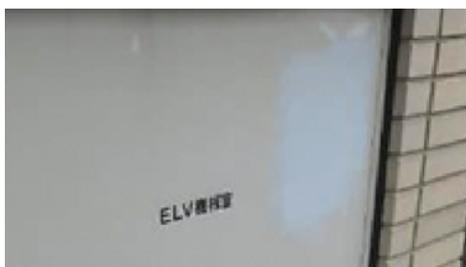
塗膜表面の劣化（変退色）
