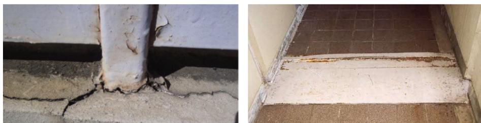
塗装の膨れと支柱付け根のひび割れ      エキスパンションジョイントの腐食
