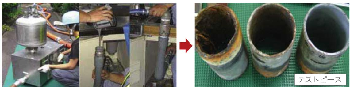
（管内の研磨） （塗料の投入） （高圧で塗布） （研磨前） （研磨後） （ライニング後）
