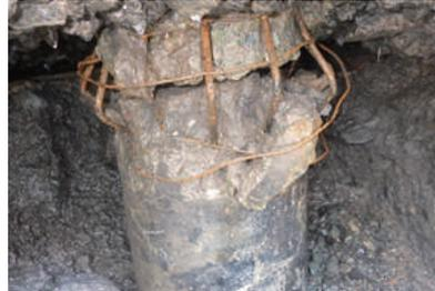
〈地盤が沈下し、液状化が発生〉
