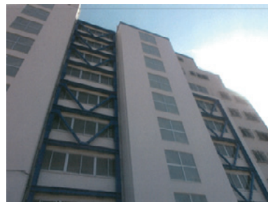
〈工事箇所（建物北面）〉
